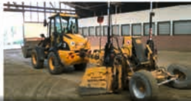
Erd- und Graderarbeiten
