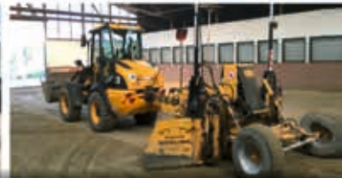
Erd- und Graderarbeiten
