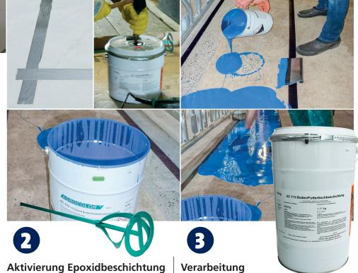
Im Eimer befinden sich die beiden Einzelkomponenten A und B der Epoxidbeschichtung, die sorgfältig miteinander vermischt
